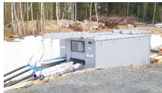
Mobila arbetsbodar användes vid arbetet med kabelskarvningen.
